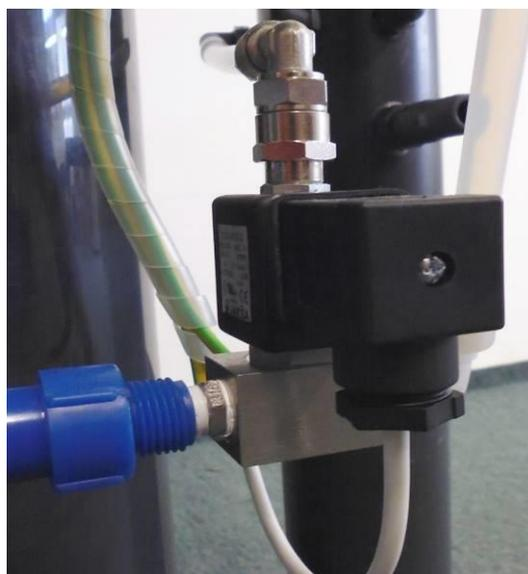
Рис. 6 Замена электромагнитного клапана O3
